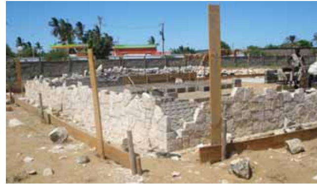
Tahala Meva Toliara: les premières fondations
